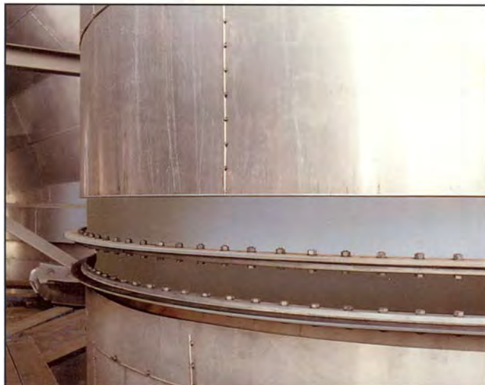
Эластомерные компенсаторы, установленные на газоходах установок газоочистки (проект компании Esmil International, Амстердам) ТЭЦ (600 МВт) в Ниймвегене.
